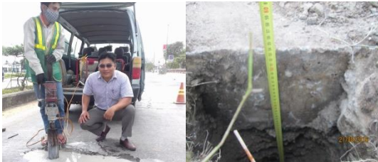
Hình 2. Công tác khoan các mẫu BTXM mặt đường và đào các hố đào phục vụ thí nghiệm
