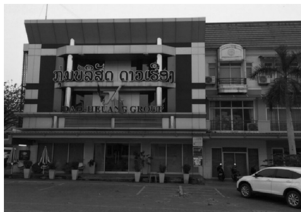
Hình 1. Trụ sở Công ty Đào Hương (Dao Heuang Group) tại thành phố Pakse, tỉnh Champasak, nơi sinh viên Phân hiệu thực tập tốt nghiệp năm 2016
