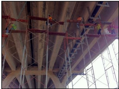
Hình 5. Lắp đặt cảm biến đo biến dạng vào đáy dầm cầu
