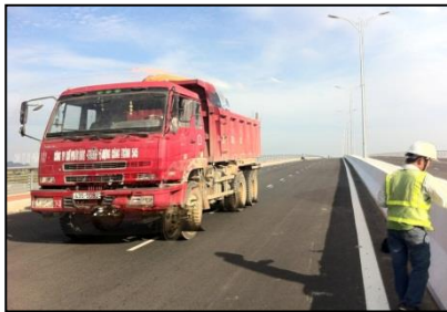
Hình 6. Hoạt tải thử nghiệm trên cầu
