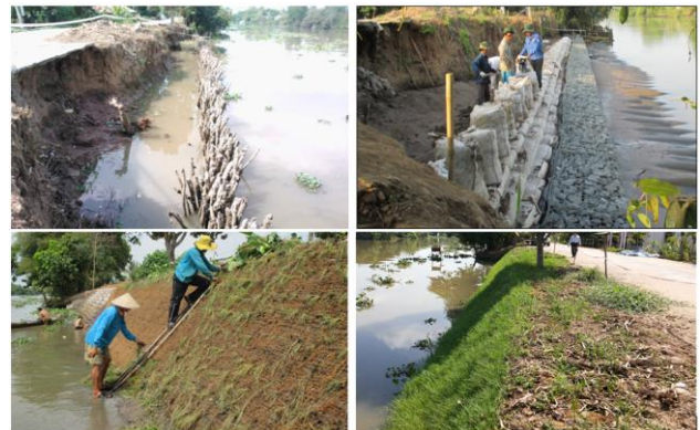
Hình 8. Ứng dụng thí điểm giải pháp bảo vệ bờ tại Tiền Giang
