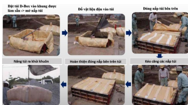
Hình 7. Thi công túi D-Box
