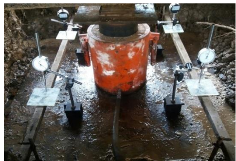
Hình 3. Lắp đặt kích, đồng hồ đo lún và thanh chuẩn
