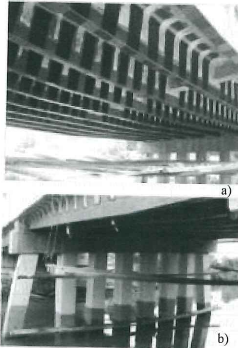
Hình 1. Gia cường cầu Chà Là Km1392+158 – QL1A, tỉnh Khánh Hòa (nguồn [5])
