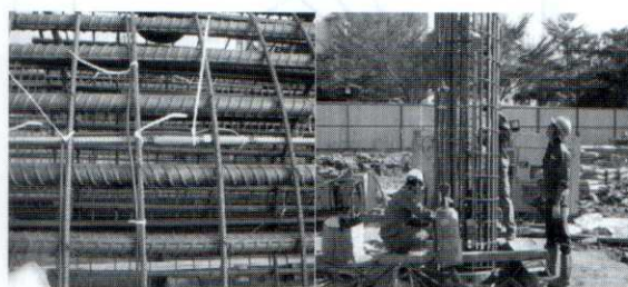
Hình 4. Lắp đặt thiết bị dây rung model 4911 vào lồng thép.
