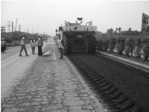
Hình 2. Mặt đường QL5 trước và sau khi thi công ứng dụng công nghệ tái chế
