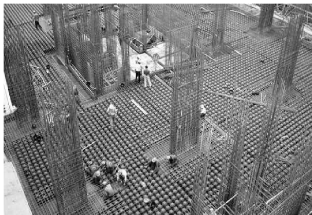
Hình 1. Thi công sàn Bubbledeck (bỏ bớt bóng ở chân cột)
