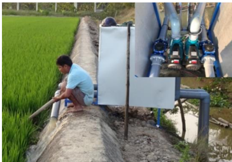
Hình 11. Thiết bị bơm nước tưới đồng ruộng Ảnh nhỏ: máy bơm và đồng hồ đo lưu lượng nước
