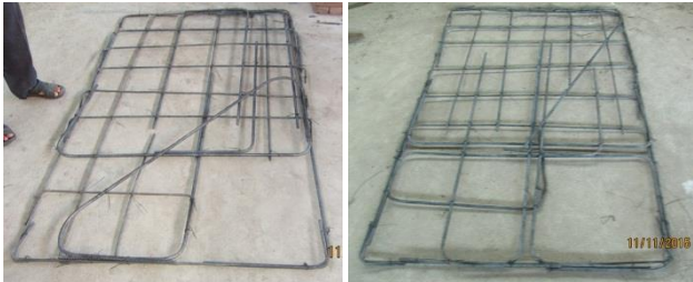
Hình 14. Lắp đặt cốt thép trường hợp 1 và 2
