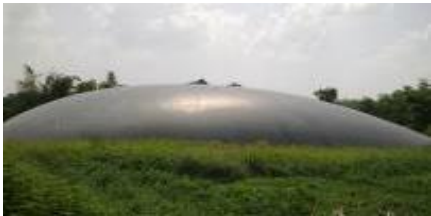
Hình 2. Bể biogas có thu hồi biogas tại Nhà máy tinh bột sắn Sơn Hải, tỉnh Quảng Ngãi
