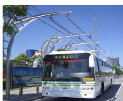
Ultracap nạp điện tại trạm dừng
