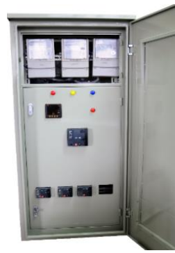
a) Tủ phân phối hoàn thiện và sơ đồ đấu nối
