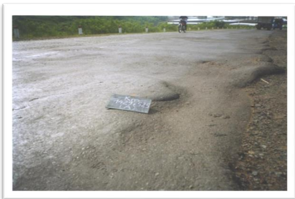
Hình 1. Lốp mặt AC đèo Rọ Tượng, QL 1A bị phá hoại do trượt
