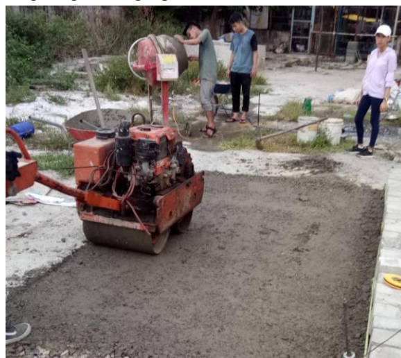
Hình 1. Hình ảnh thực tế đoạn thi công thử nghiệm
