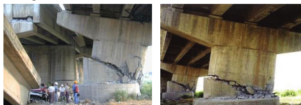
Hình 2. Phá hoại của trụ cầu Wu-Shi sau động đất Chichi Đài Loan năm 1999 [4]
