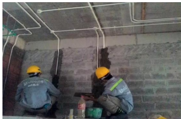
Hình 2. Công đoạn thi công lắp ống âm tường
