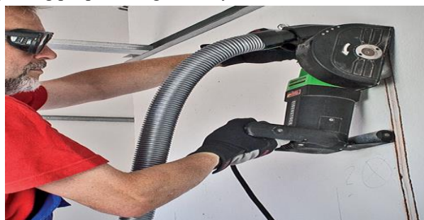
Hình 1. Thao tác cắt rãnh tường thủ công
