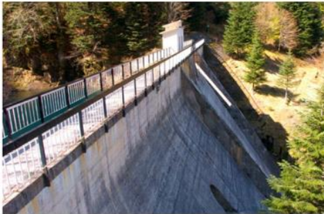
Nhìn từ hạ lưu Đập Torán
