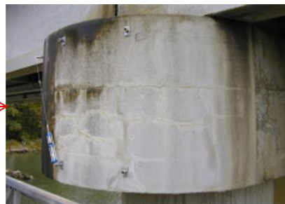
Vết nứt ở đầu dầm ngang ở trụ pin P2, năm 2005
