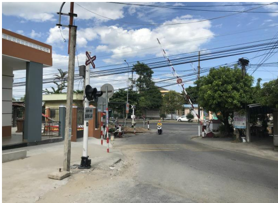
Hình 9. Hình ảnh đường ngang Km777+610 tự động không có người gác
