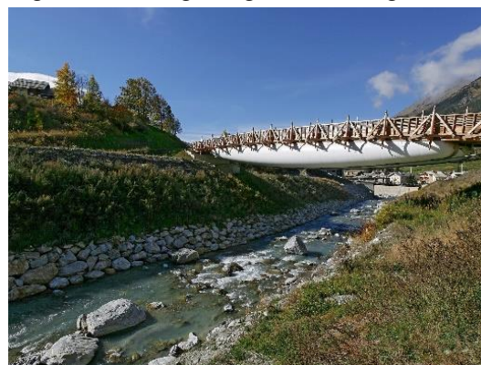
Hình 2. Kết cấu cầu có sử dụng ống thổi phòng [2]
