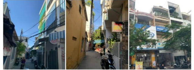
Hình 3. Nhà phố trên địa bàn quận Hải Châu và Thanh Khê, TP Đà Nẵng
