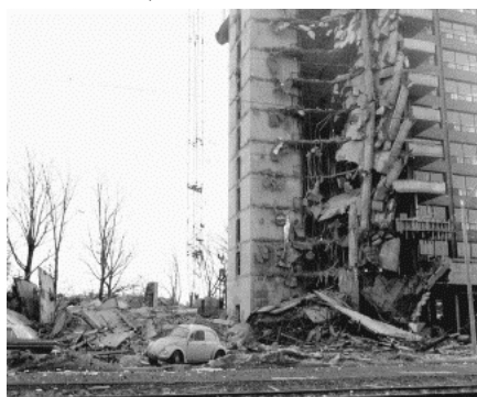
Hình 1. Sự sụp đổ của chung cư 2000 Commonwealth Avenue, Boston, Massachusetts, Hoa Kỳ do phá hoại nền thủng
