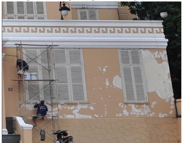
Hình 6. Công trình số 42 Bạch Đằng (Đà Nẵng) nay là Bảo tàng Đà Nẵng. Mặt tiền xuất hiện vô số vết nứt mặc dầu đã qua rất nhiều lần sửa chữa (nguồn: hình chụp của NTG năm 2011)
