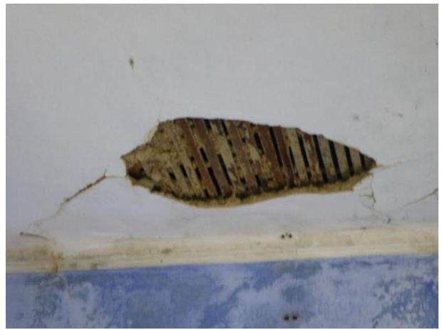
Hình 5. Công trình ở số 51 Hai Bà Trưng (Huế) được tạm sử dụng là nơi làm việc của CT Xây lắp Bưu điện, với hệ sàn trần bằng cốt tre kết hợp vôi (nguồn: hình chụp của NTG)
